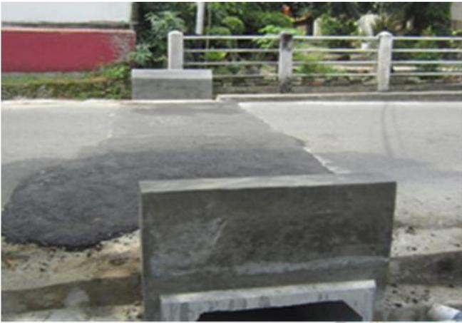
15. 16. Pembangunan Box Culvert RW III Tanjung Uban Utara Kec. Bintang Utara (10 M x 2 M) (1 buah), Pagu Anggaran Pakert Pekerjaan (DPA) sebesar Rp.250.000.000. Box culvert tersebut berfungsi untuk menggantikan Box culvert yang ada saat ini karena sudah rusak dan sempit serta mengurangi genangan air apabila terjadi hujan. Kegiatan ini dilaksanakan oleh Satuan Kerja Perangkat Daerah Dinas Pekerjaan Umum Kabupaten Bintan. Paket pekerjaan dalam tahap penyelesaian.
