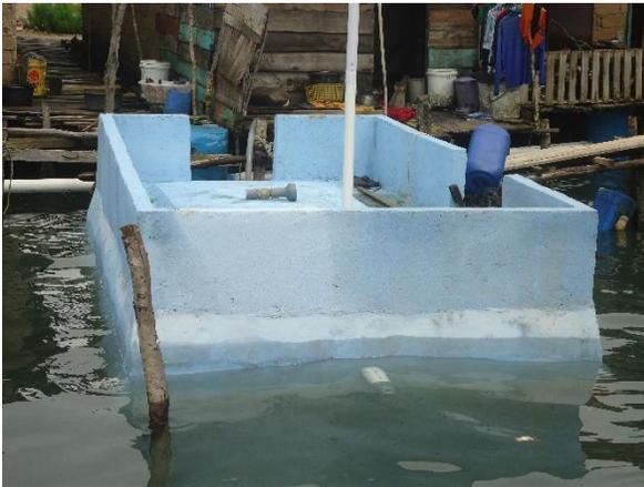
lokasi pembangunan dimana saluran pembuangan yang dibangun menurut mereka tidak sesuai untuk lokasi septic tank rumah darat, sambungan pipa juga ada yang bocor, kebocoran ini juga terdapat pada septic tank yang berada di laut yang beberapa diantaranya jika air pasang mengeluarkan bau tak sedap. Diingatkan kepada Dinas Pekerjaan Umum untuk tetap melakukan pengawasan terkait rencana pembangunan dan kualitas bangunan yang dikerjakan oleh kontraktor.
