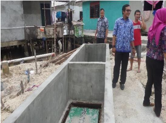
kembali kepada Dinas Pekerjaan Umum untuk mengawasi pekerjaan yang berlangsung agar dapat memastikan nilai bangunan yang dikerjakan berkualitas baik. Hal ini untuk meminimalisir terjadinya kebocoran pipa sambungan seperti yang ditemukan pada pembangunan IPAL sebelumnya.
